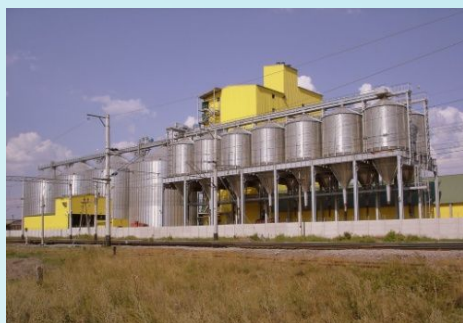
ЗАО «Новооскольский комбикормовый завод»
