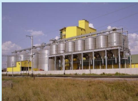
ЗАО «Новооскольский комбикормовый завод»
