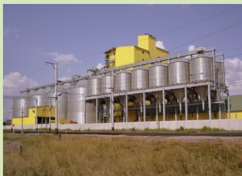
ЗАО «Новооскольский комбикормовый завод»
